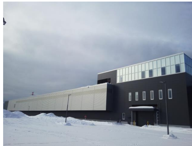
石狩データセンター 3号棟
