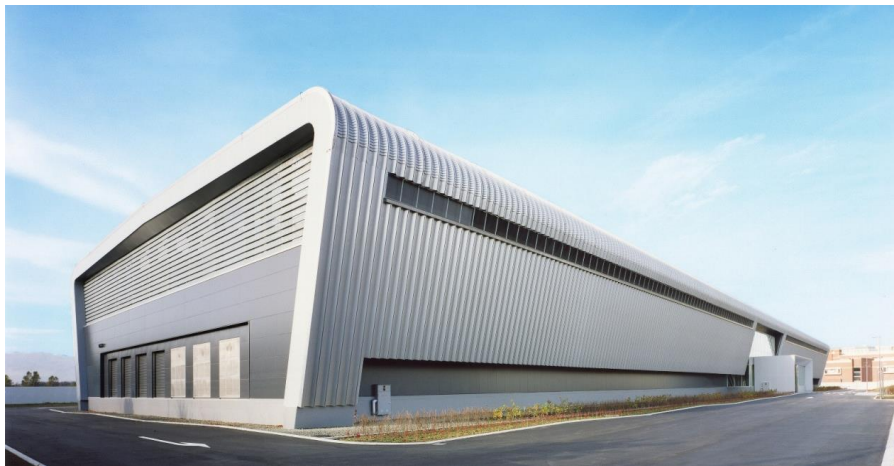
石狩データセンター 1,2号棟
